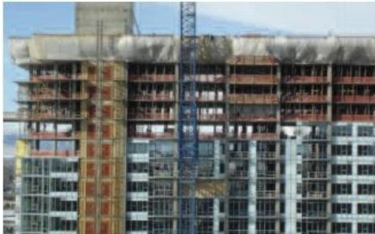
L'alto edificio contiene due nuclei di calcestruzzo massivo con pareti spesse fino a tre piedi pari a un quantitativo di circa 8,000 yarde cubiche di SCC ove è stato utilizzato il nuovo additivo ADVA<sup>®</sup>408.
